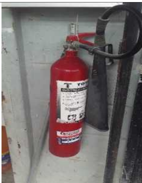
9.- EXTINTOR EN AREA DE CAMPAMENTO
