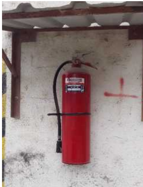
16.- EXTINTOR EN AREA DE BODEGA
