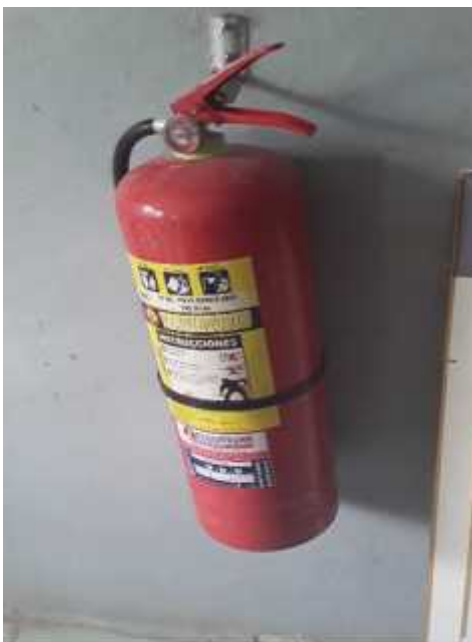
10.- EXTINTOR EN AREA DE COMEDOR
