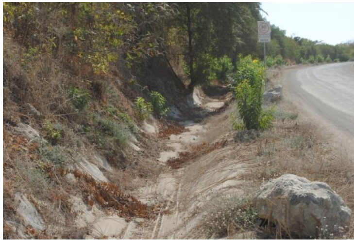
Foto 6- 2: Canal de drenaje periférico ubicado en el sector oeste.
