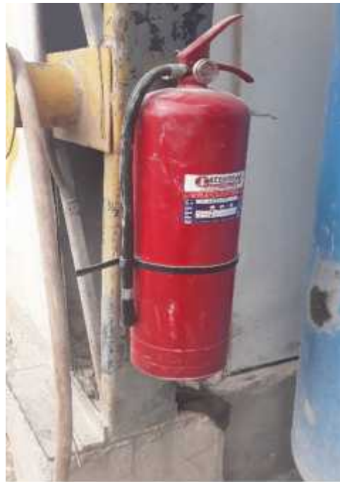
12.- EXTINTOR EN AREA DE TALLER-COMPRESOR
