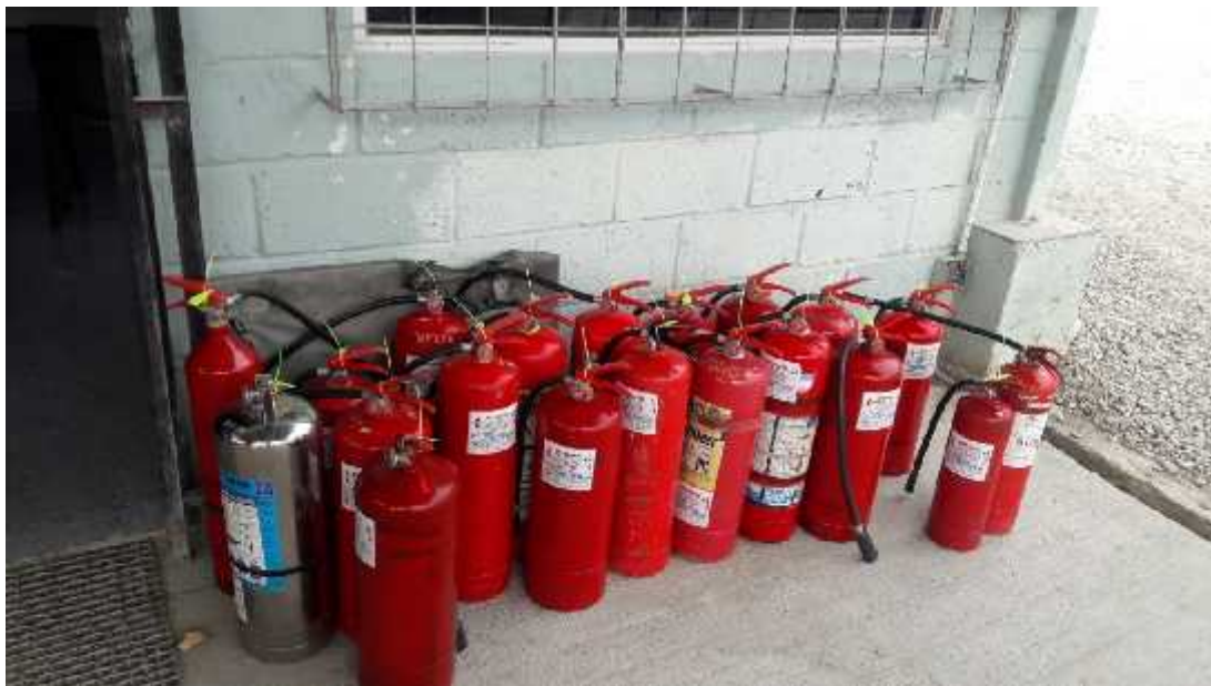
8.- EXTINTORES A SER RECARGADOS SEGÚN FECHA DE CADUCIDAD
