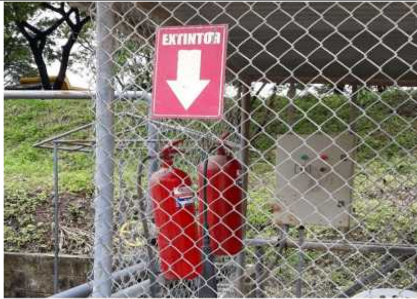
7.- EXTINTOR EN AREA DE SURTIDOR
