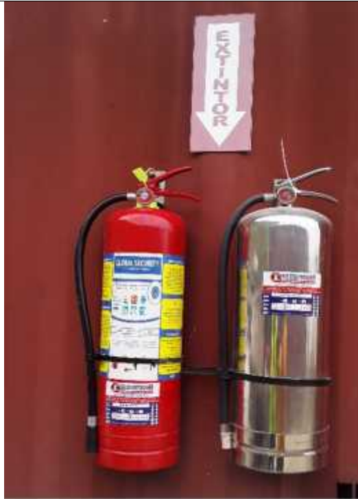
15.- EXTINTORES EN AREA DE POLVORIN
