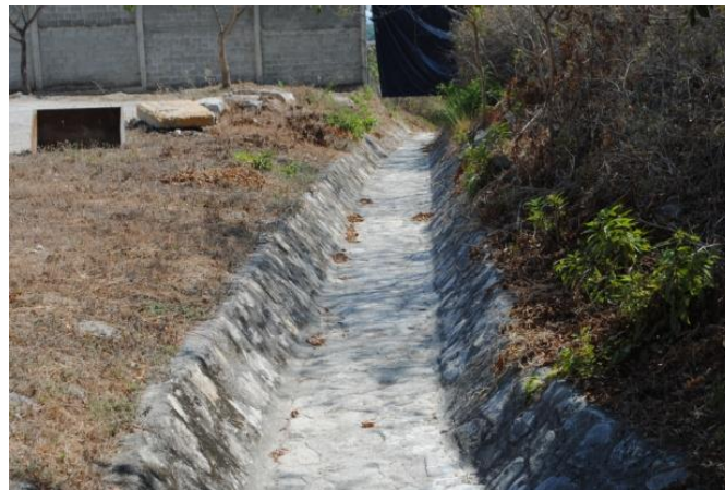
Foto 6- 1: Canal de drenaje periférico ubicado en el sector sur.
