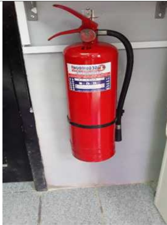
14.- EXTINTOR EN AREA DE OFICINA
