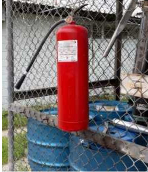
1.- EXTINTOR EN ÁREA DE LUBRICANTES
