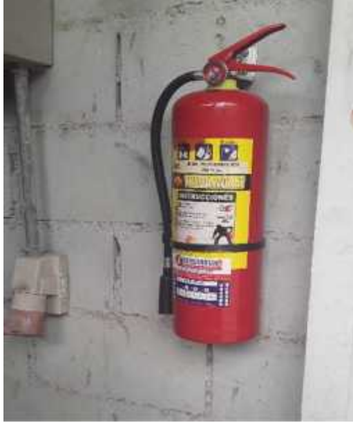
11.- EXTINTOR EN AREA DE VESTIDORES
