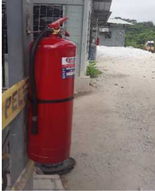
13.- EXTINTOR EN AREA DE TALLER
